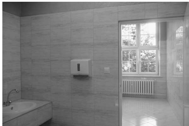
Ostatnia z remontowanych toalet dla uczniów
